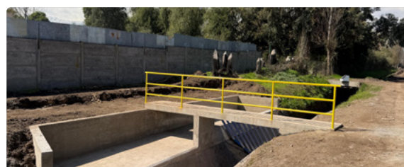
Vertedero de seguridad canal Lo Solar.
