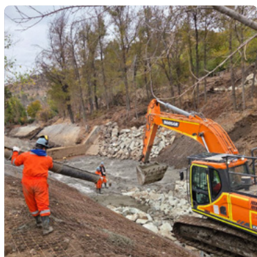
Obras de protección canal Rápido de Descarga en Central Florida.
