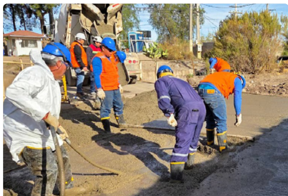
Construcción de radier en desarenador.
