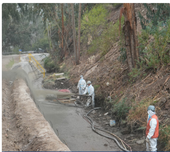
Revestimiento de canal El Carmen sector Paperchase.
