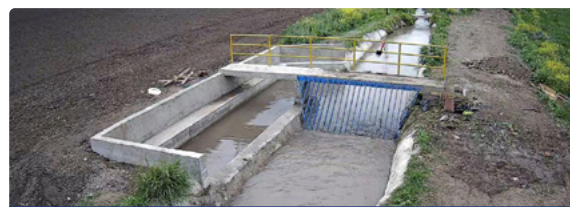
Vertedero de seguridad canal Batuco.
