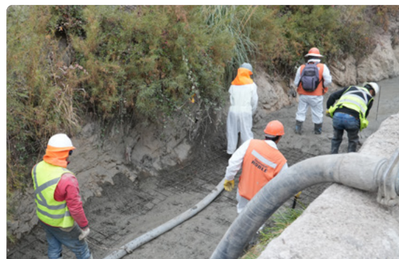
Radier canal El Carmen entre túnel San Ignacio y túnel Español.
