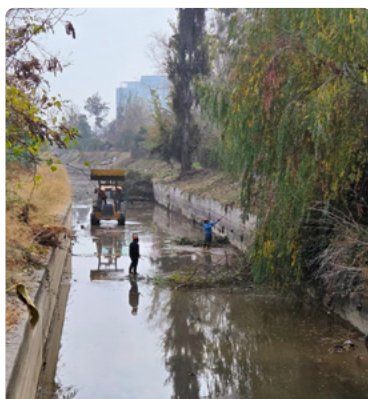
Mantenimiento y limpieza de canal San Carlos Nuevo.
