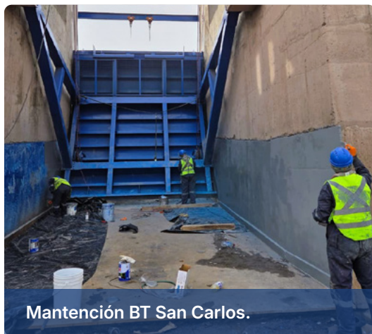
Construcción de sección de aforo en canal San Carlos Viejo.
