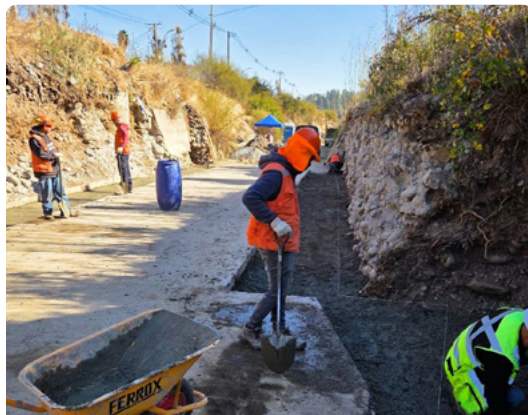
Construcción de sección de aforo en canal San Carlos Viejo.
