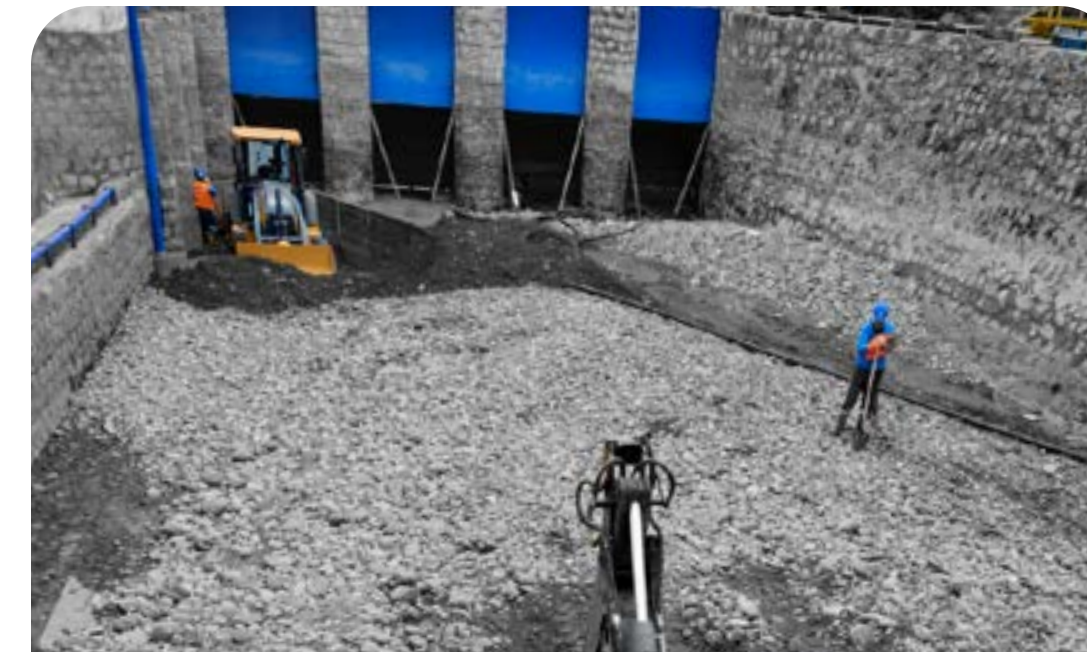
Mantención Bocatoma San Carlos.
