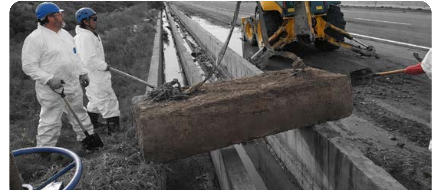
Limpieza de canal en Comunidad Pudahuel.
