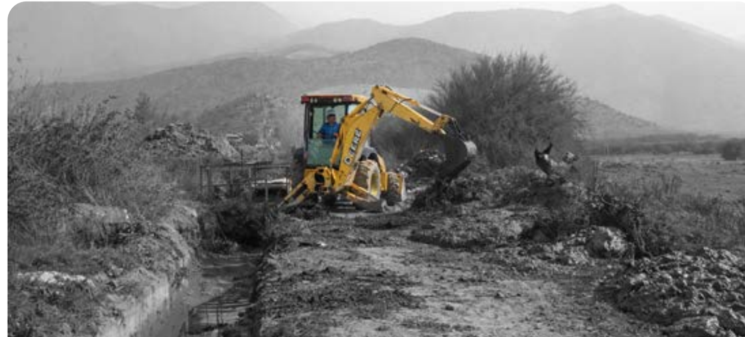
Limpieza de canal en Comunidad Juan Antonio Ríos.
