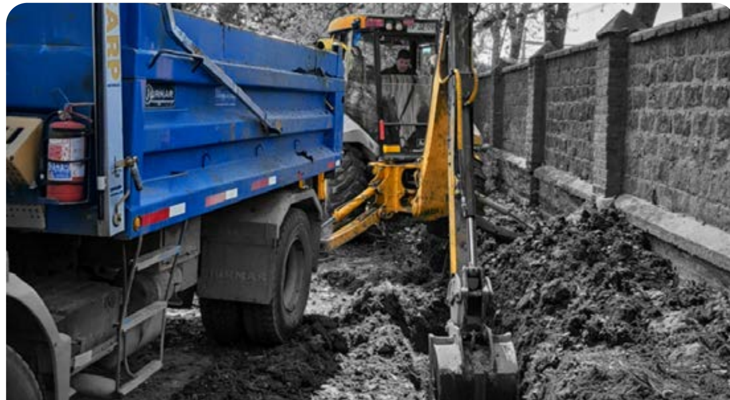
Limpeza de canal con maquinaria en Comunidad San Antonio de Tango.
