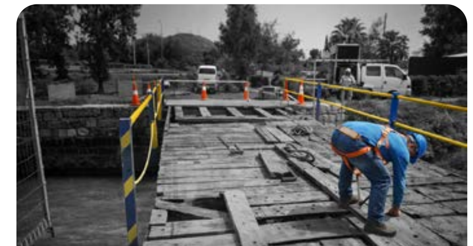
Reparación del puente en recinto Las Vizcachas.
