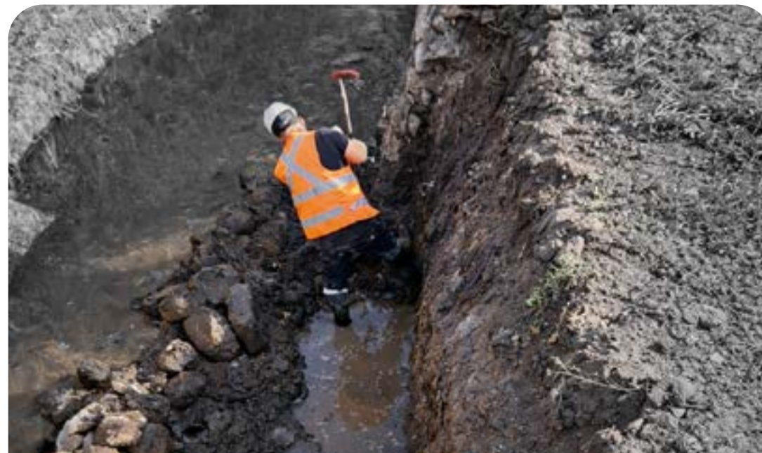
Canal El Carmen: Reparación de emergencia muro.
