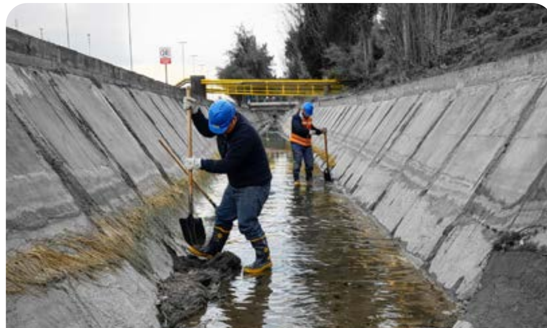
Limpieza del canal Las Perdices al interior de planta de agua potable en Las Vizcachas.
