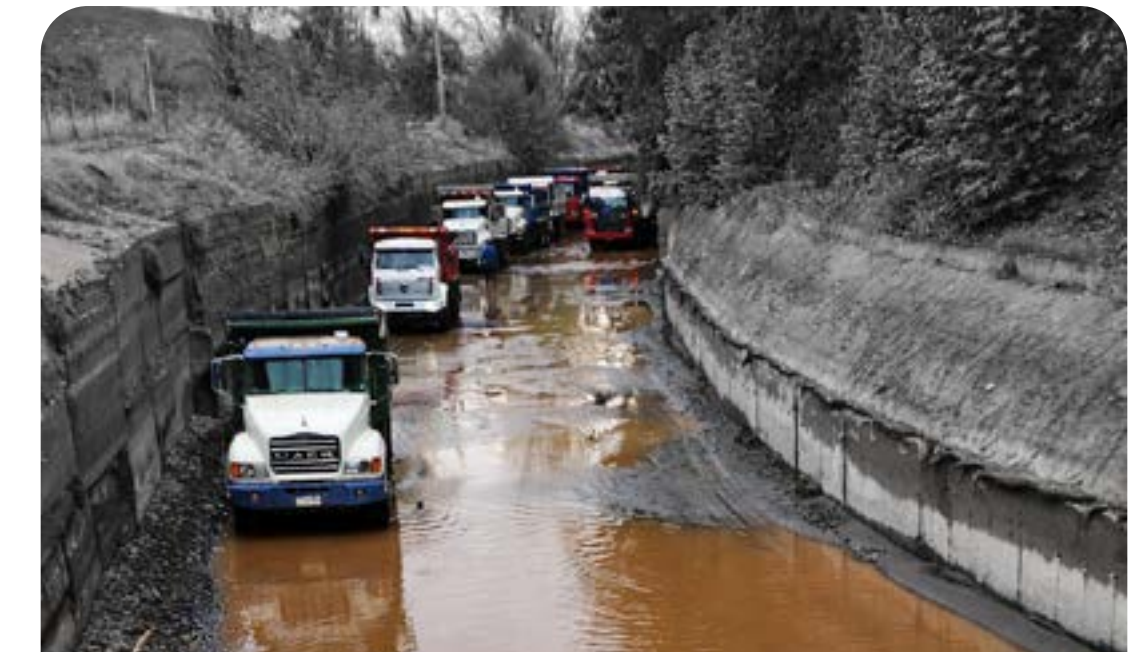
Limpieza Canal San Carlos Tronco.
