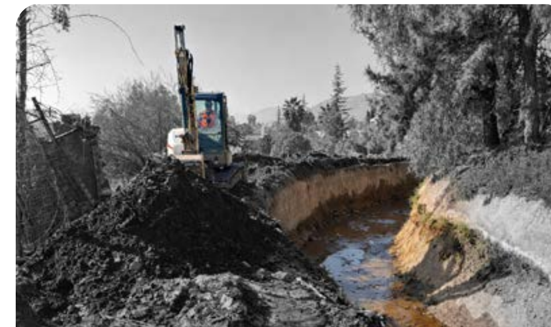
50 metros lineales de mejoramiento del fondo del Canal Batuco y murete de seguridad, en Quebrada La Ñipa.
