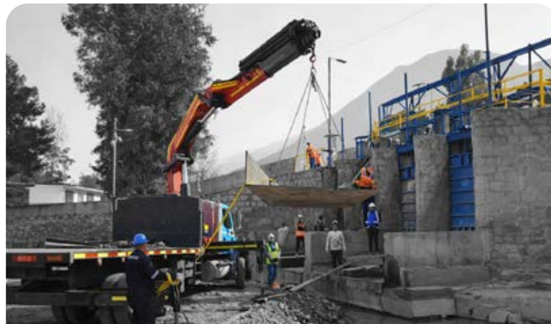
Obras civiles en Bocatoma San Carlos.
