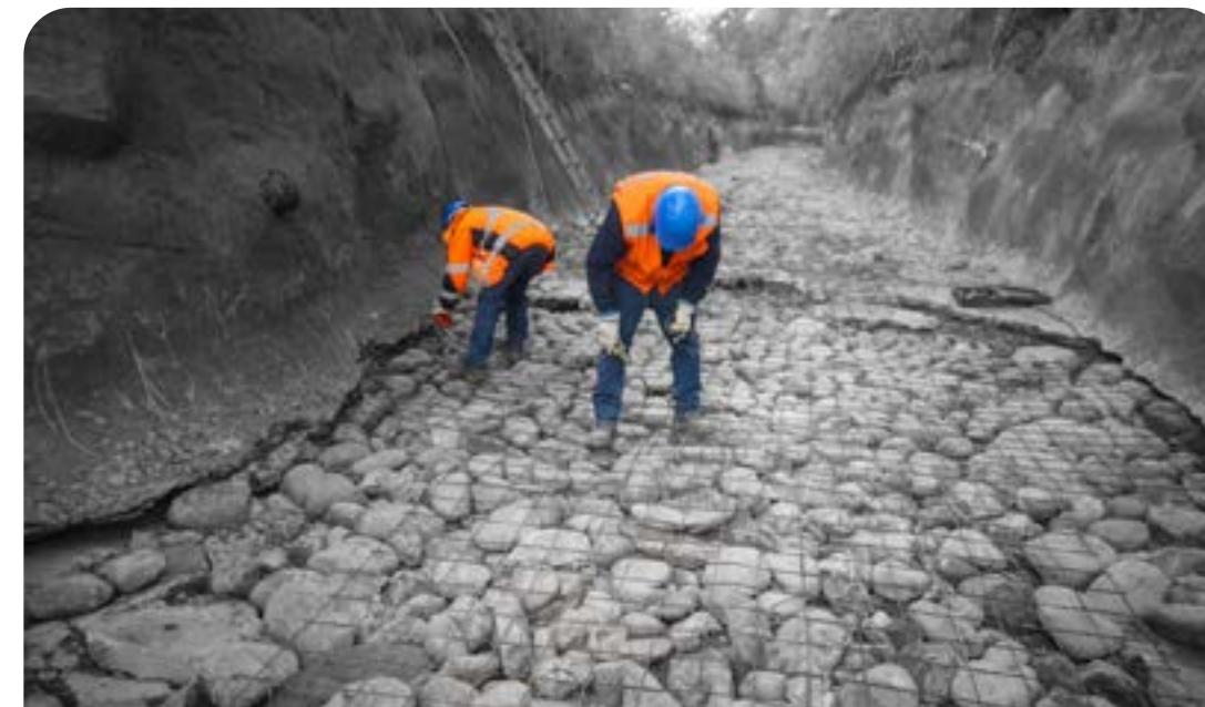
Reparación radier Canal San Carlos Tronco.
