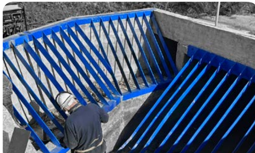
Mantención de compuertas y estructuras metálicas en red de canales.
