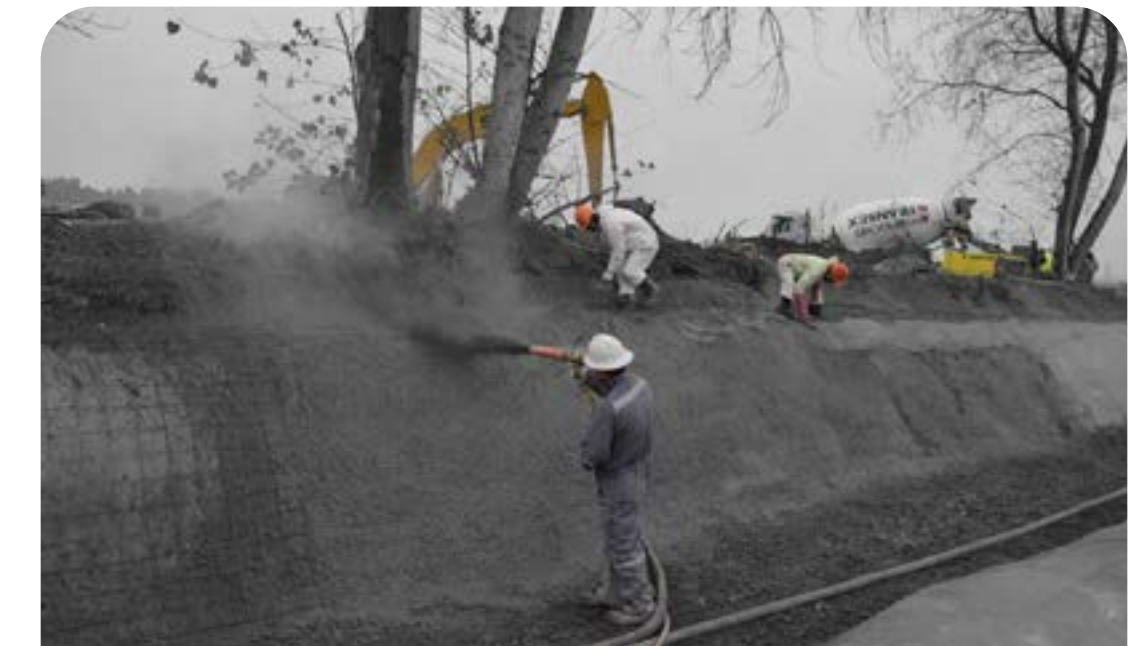
Revestimiento Canal La Punta.
