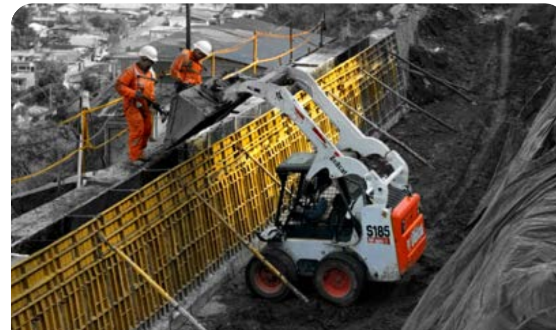
Muro camino de borde Canal El Carmen en el sector sur de la Avenida Recoleta.
