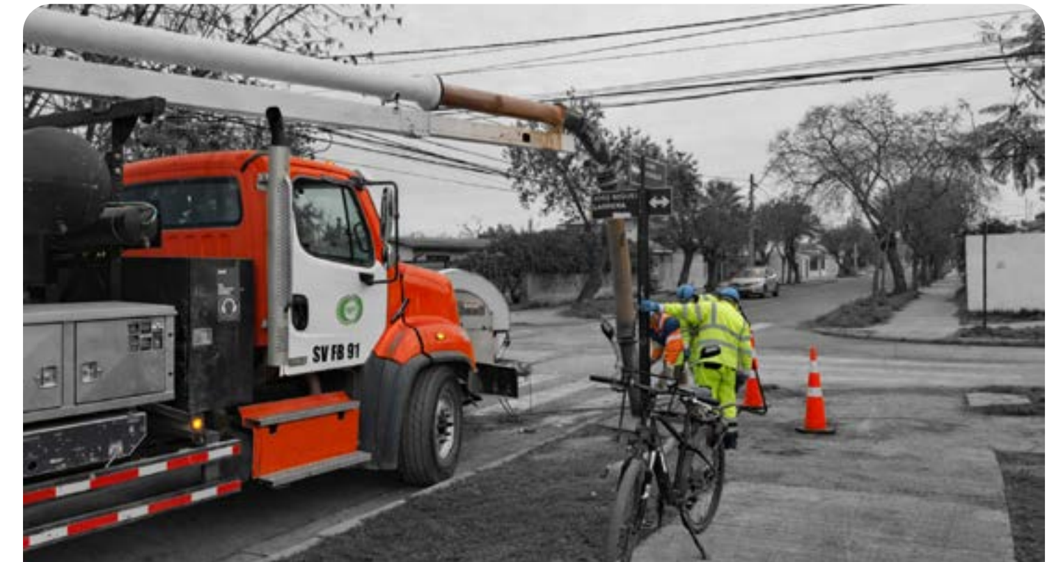
Limpeza de tuberías con camión multipropósito en comunidad La Lata.
