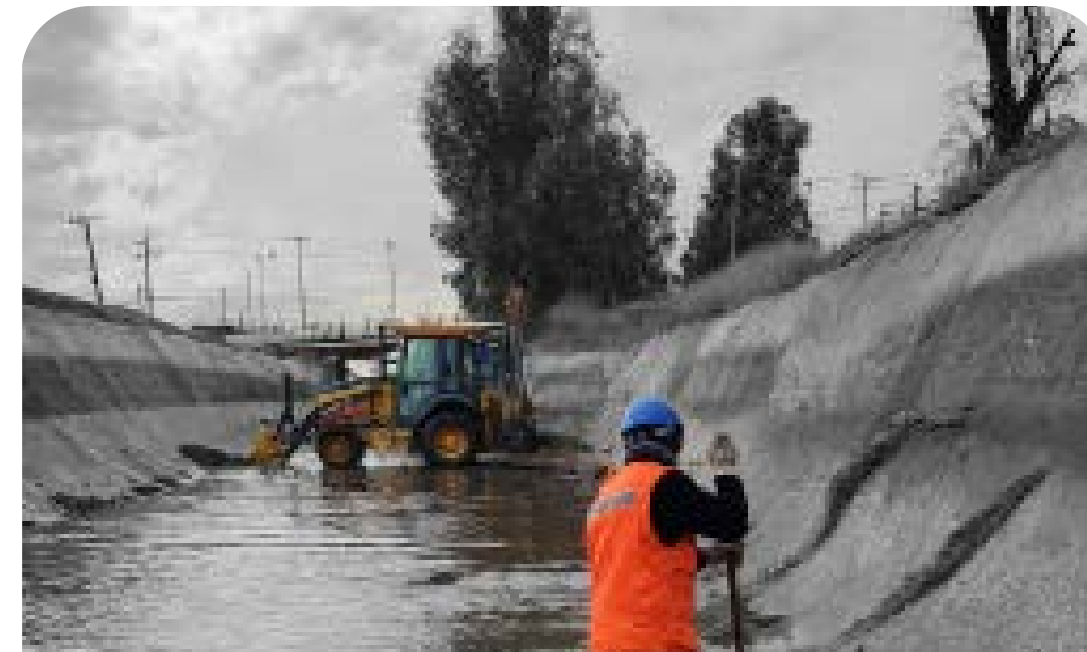
Mantención Canal Florida.
