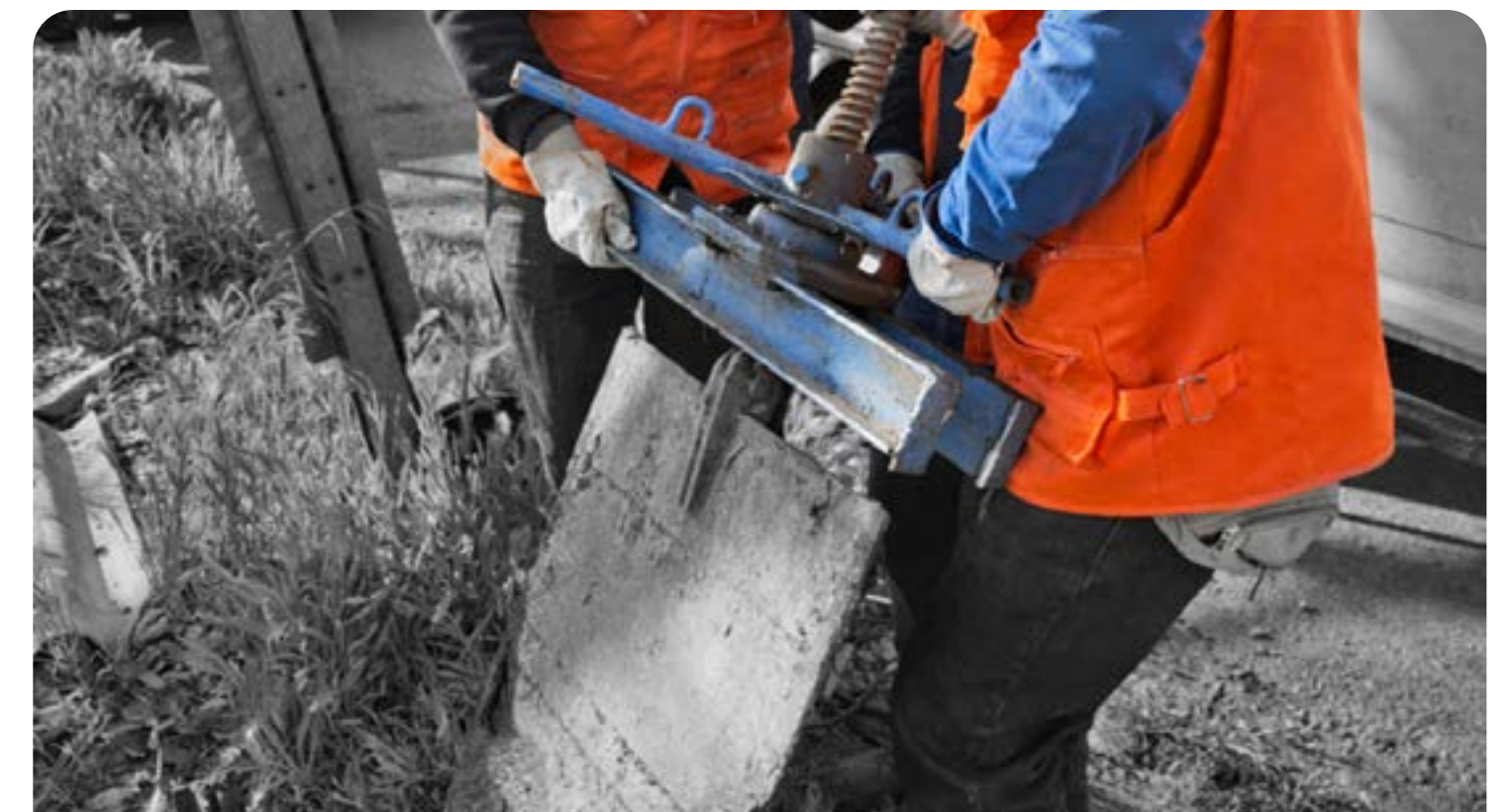
Reparación de compuerta en sector El Mariscal.
