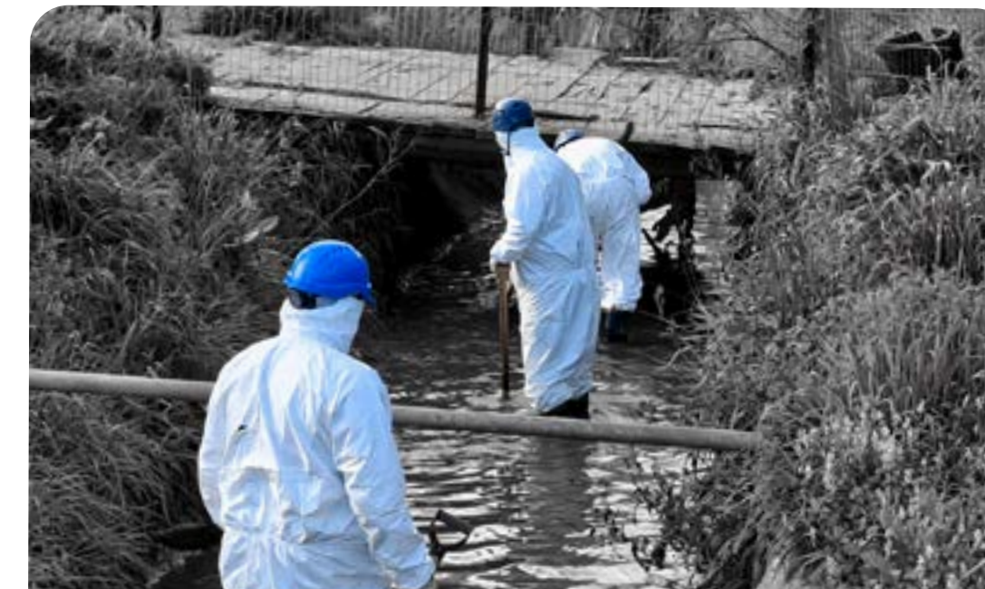
Limpieza Canal Lo Solar.
