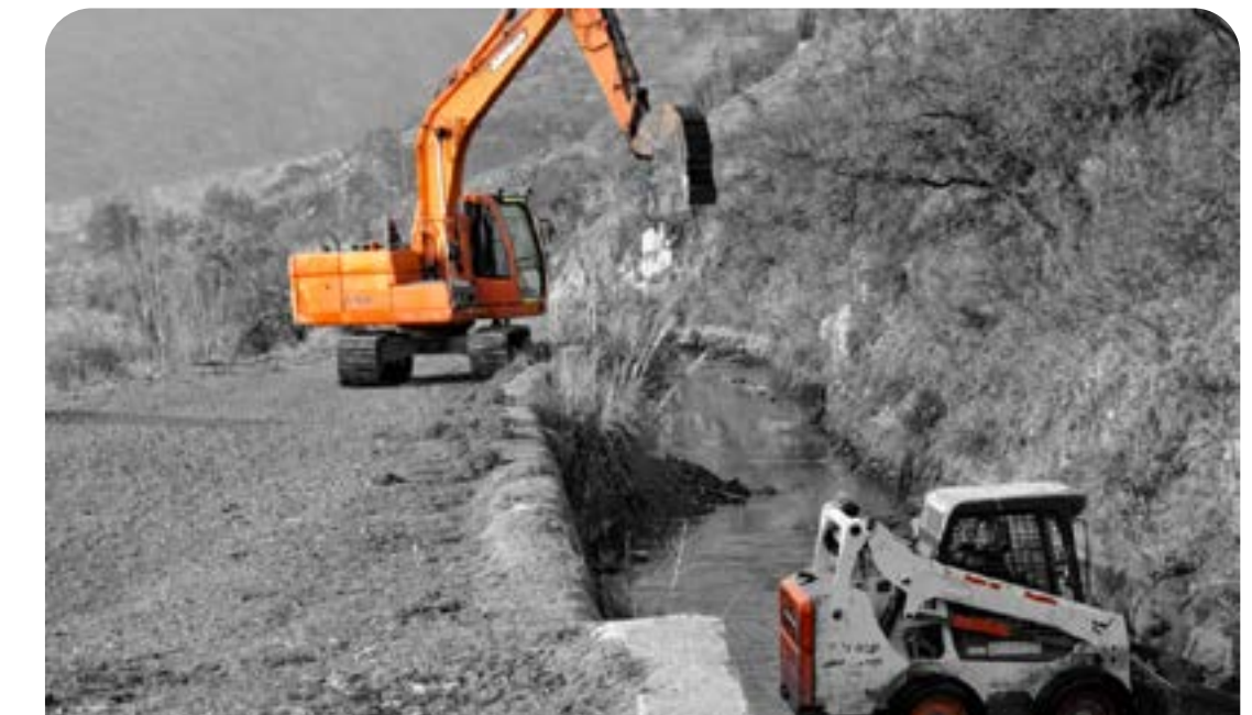
Limpieza Canal El Carmen.
