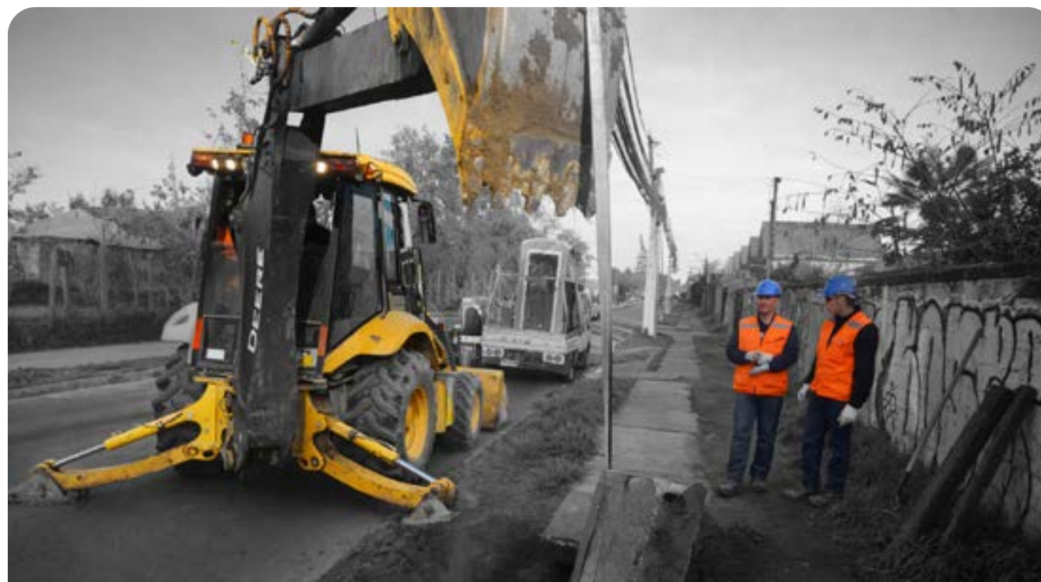
Reemplazo de losa en comunidad Las Granjas Antiguas.
