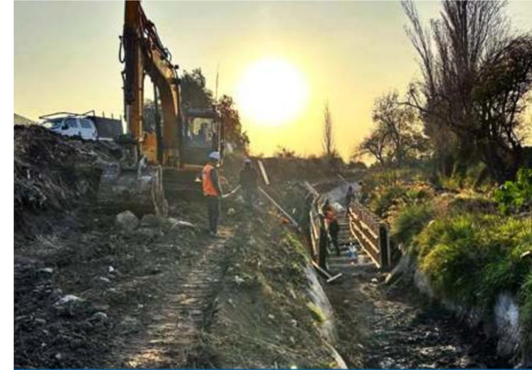
Canal Batuco, construcción 250 metros lineales de revestimiento radier y muros en hormigón, sector La Reserva.
