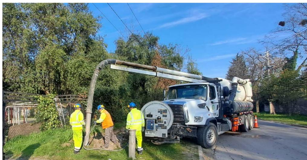
Limpieza de tuberías con camión combinado.
