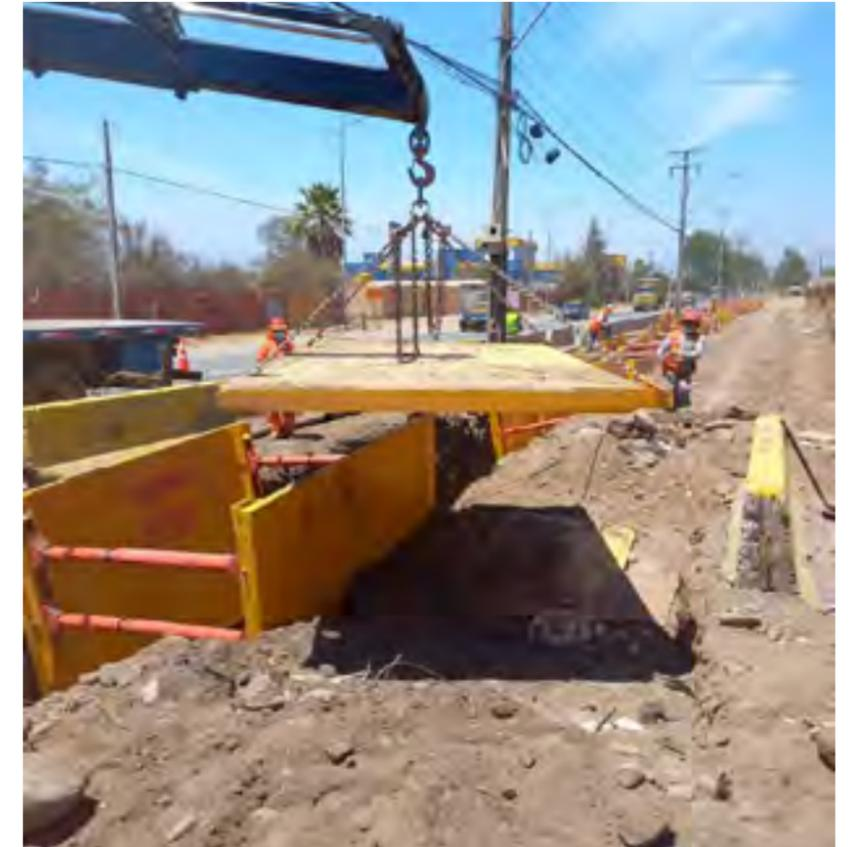
Aguas Andinas instaló una tubería de impulsión para el transporte de agua cruda que va paralela a nuestro canal Rama San Bernardo.
