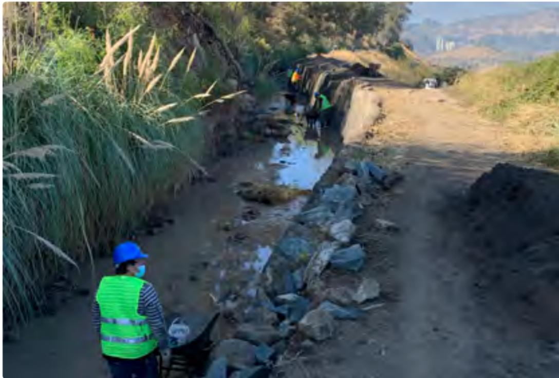
Con el fin de generar una mejor conducción del agua, se renovó el revestimiento original del canal, que contaba con muros de piedra. Este es uno de los trabajos recurrentes, dada la antigüedad de su infraestructura.
