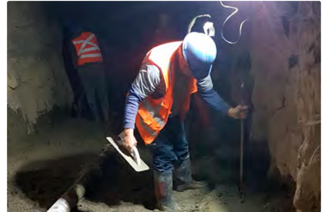
Esta obra permite mejorar la conducción del agua dentro de los túneles. Al estar la obra arriba del cerro, se necesitó bombear el hormigón a más de 50 metros de altura para ingresarlo al túnel y luego nivelarlo.
