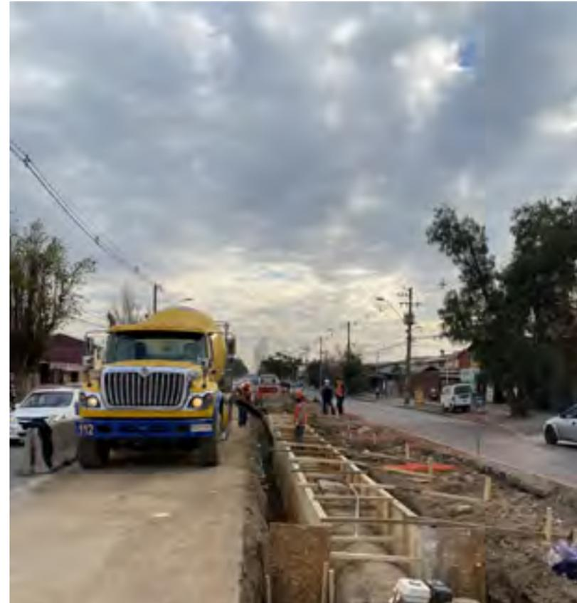
Tras la creación de una pista de viraje sobre el canal, debido a obras de mitigación vial, fue necesario protegerlo con obras de hormigón.
