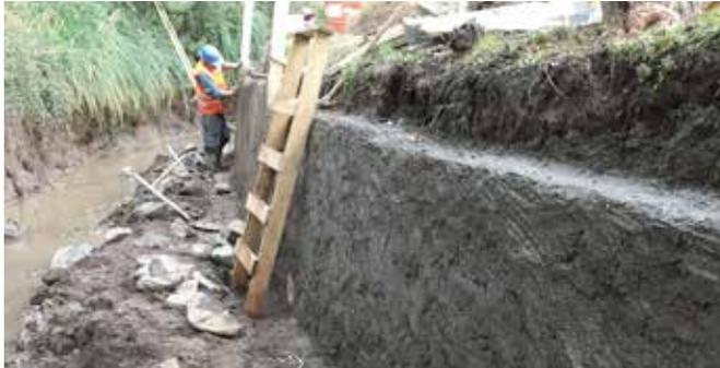
Para disminuir el riesgo de operación del canal, se construyó el muro por el lado izquierdo en el sector de Portezuelo, donde el canal va por la ladera del cerro. La obra tiene una longitud de 262 m.
