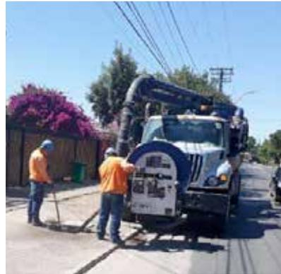
Limpieza de tubería con camión Hidrojet.
