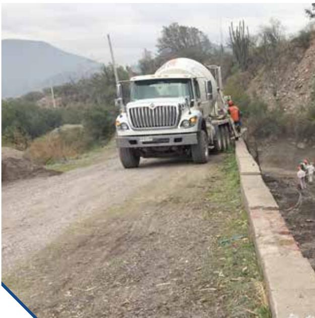
En el sector del Fundo El Raco se revistieron 400 m del lado derecho del canal, con una altura promedio de 2 m, para evitar el desprendimiento de material y mejorar el escurrimiento del agua.
