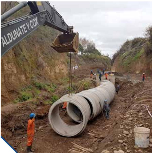
Continuando con las labores de entubado iniciadas en 2016, se instaló un nuevo tramo de 350 m de tubos de hormigón armado -de 2.000 mm de diámetro- aguas abajo del puente de Av. El Peral.
