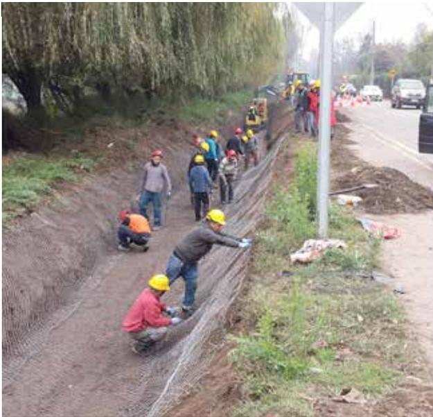
Buscando mejorar las condiciones hidráulicas, se revistió el canal en toda su sección y por una longitud de 758 m.
