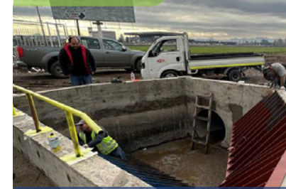
Construcción de vertedero de seguridad para control de desbordes
