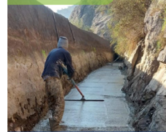
Construcción de 270 metros lineales de radier
