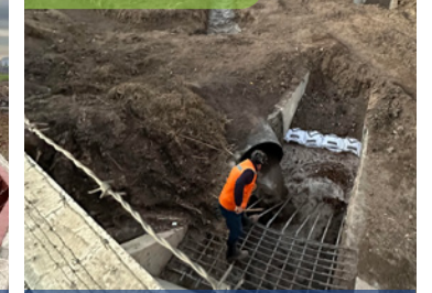
Instalación canaletas y construcción de bypass provisorio
