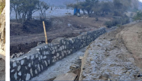
Reconstrucción de 185 metros lineales de muro
