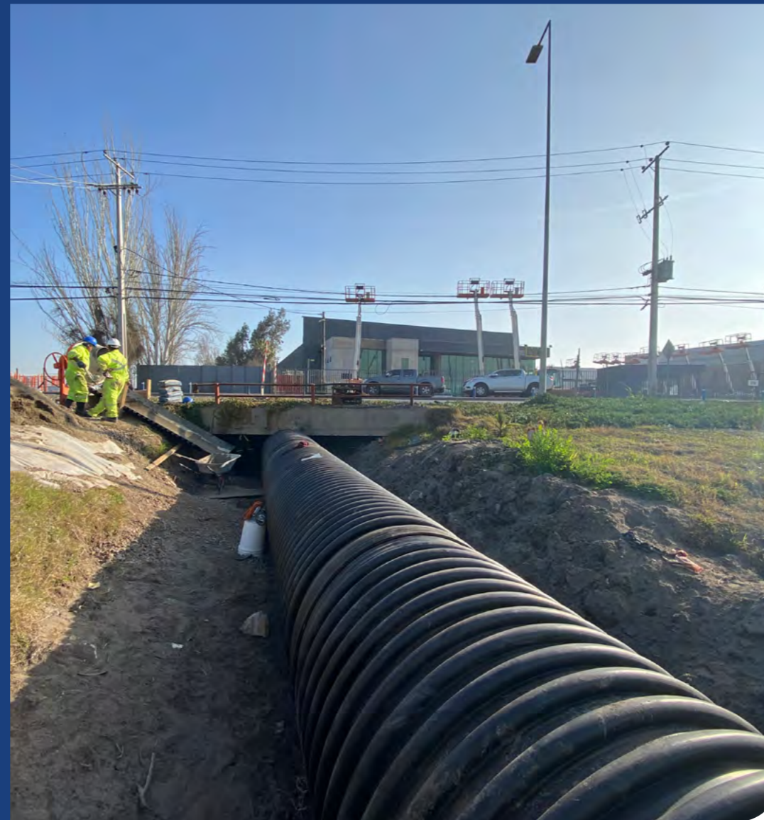
Abovedamiento del Canal Lo Castro en cruce con la Ruta 5 Norte.
