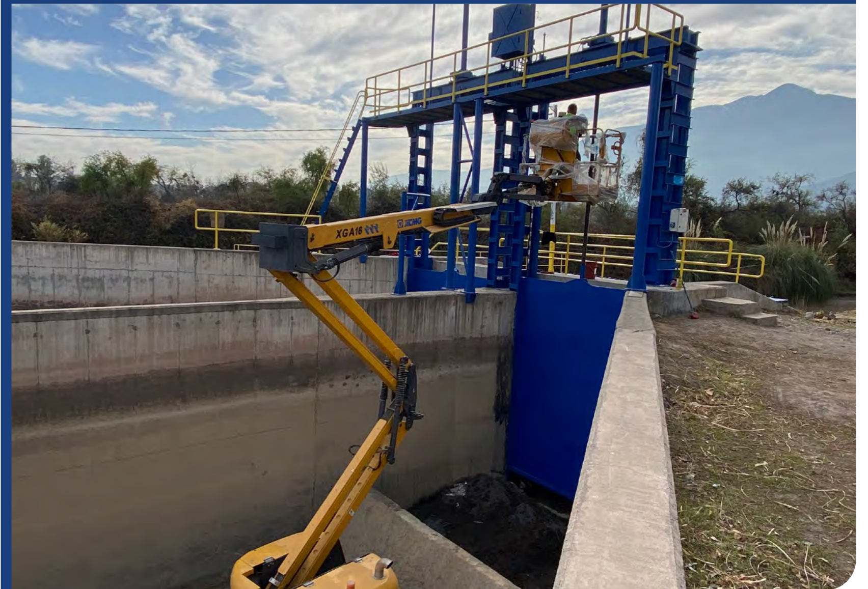
Mantenimiento en las compuertas del Desarenador Eyzaguirre.
