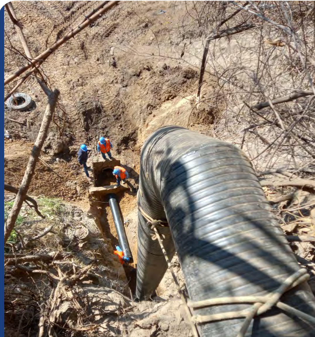
Construcción de desagüe en la comunidad Legionarios de Cristo.
