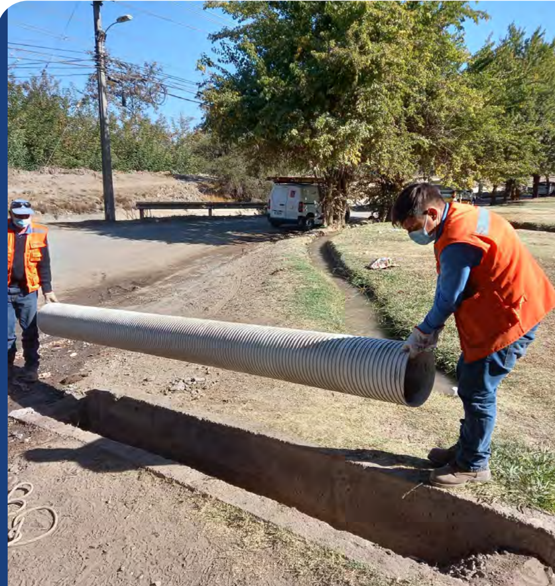
Instalación y reparación de acequia de la comunidad Santa Victoria.
