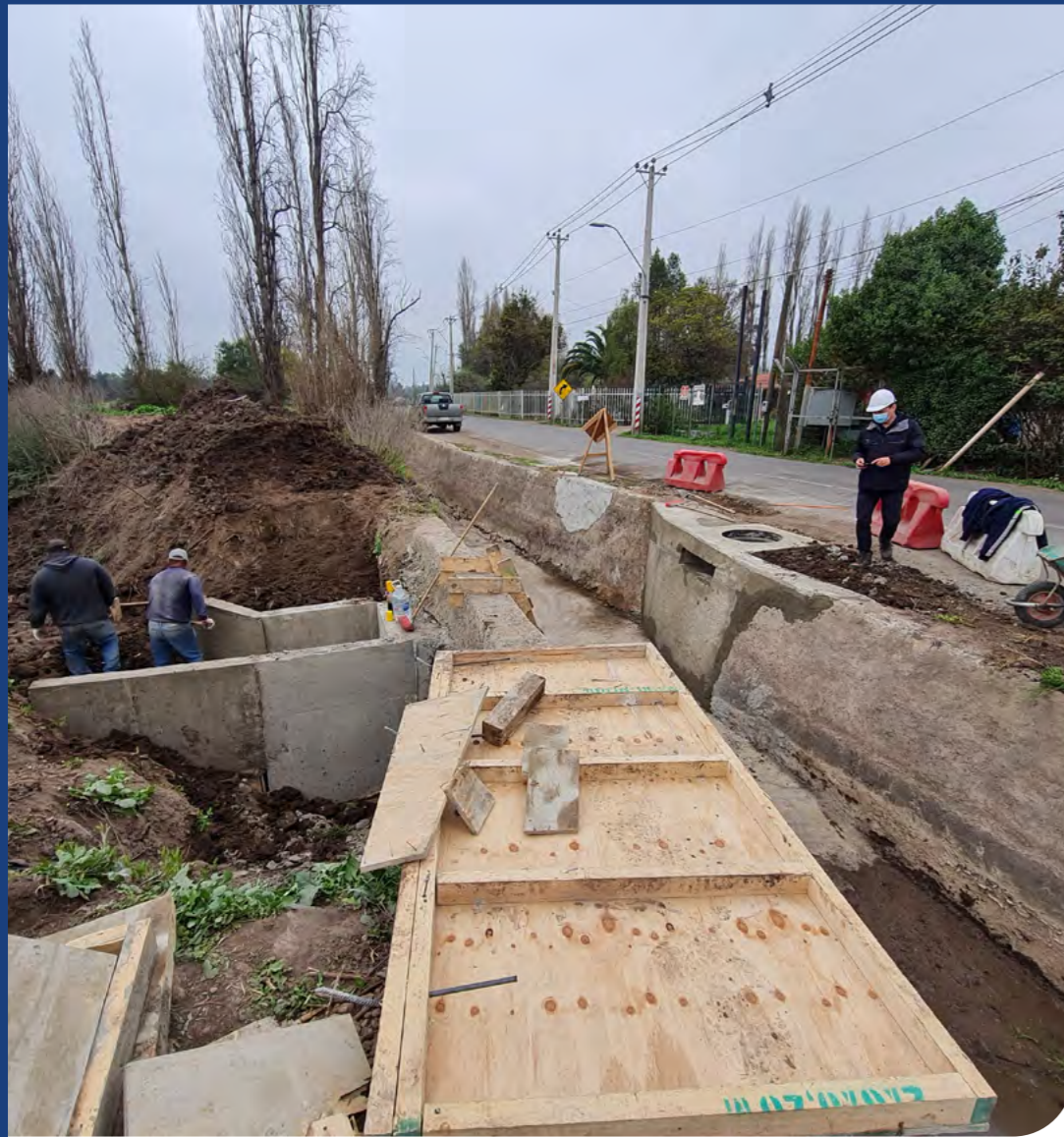
Construcción de sifón en la comunidad Casas del Alba.
