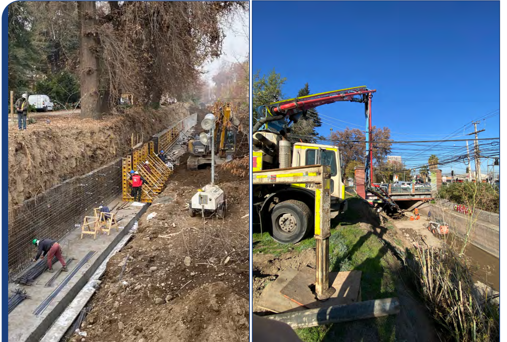
1.400 metros de muro derecho y radier en Canal San Carlos, entre Departamental y Quilín.
