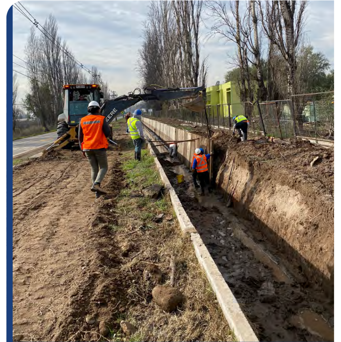
Canal La Punta, reparación de muro en sector Noviciado.
