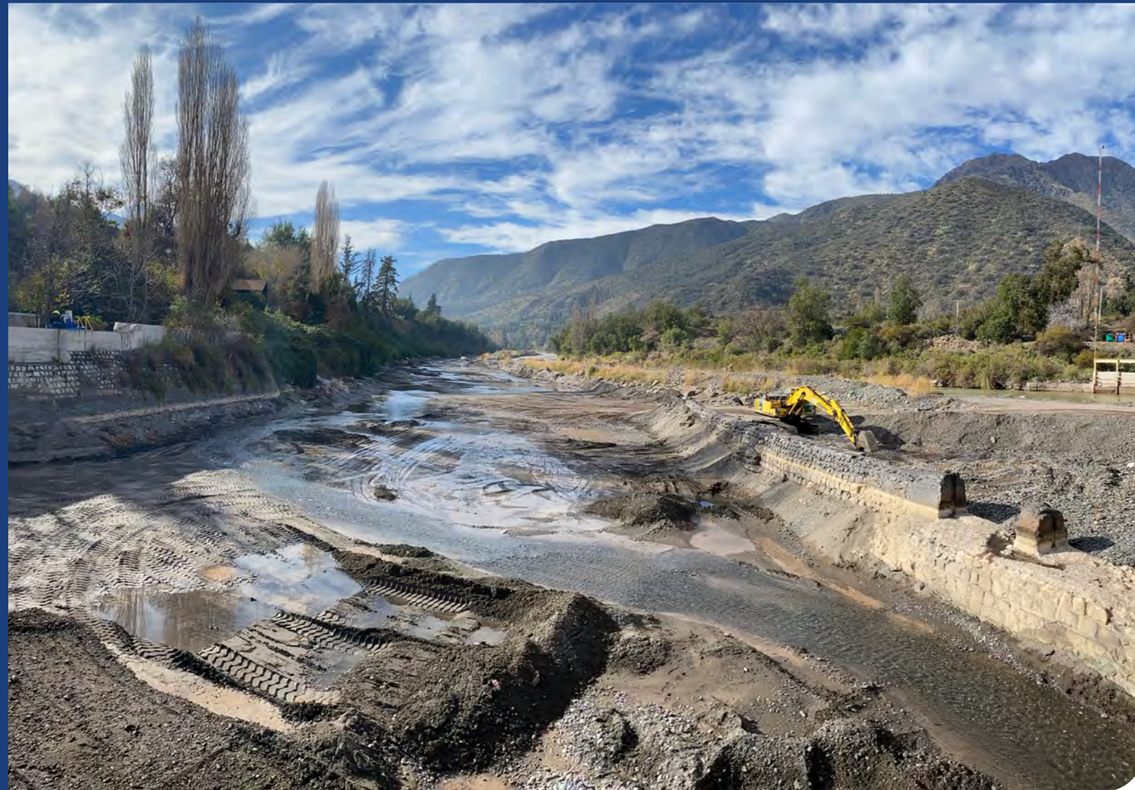
Limpieza del Río Maipo en sector de la Bocatoma San Carlos.
