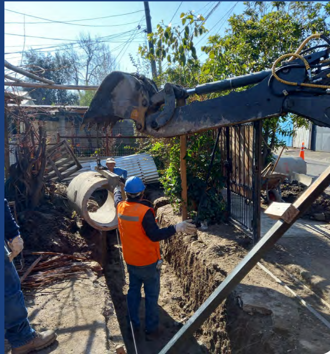
Reparación de canal en comunidad Casas Viejas.
