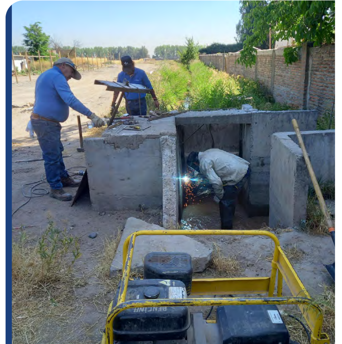
Reparación de compuerta en la comunidad Villa Las Rosas.
