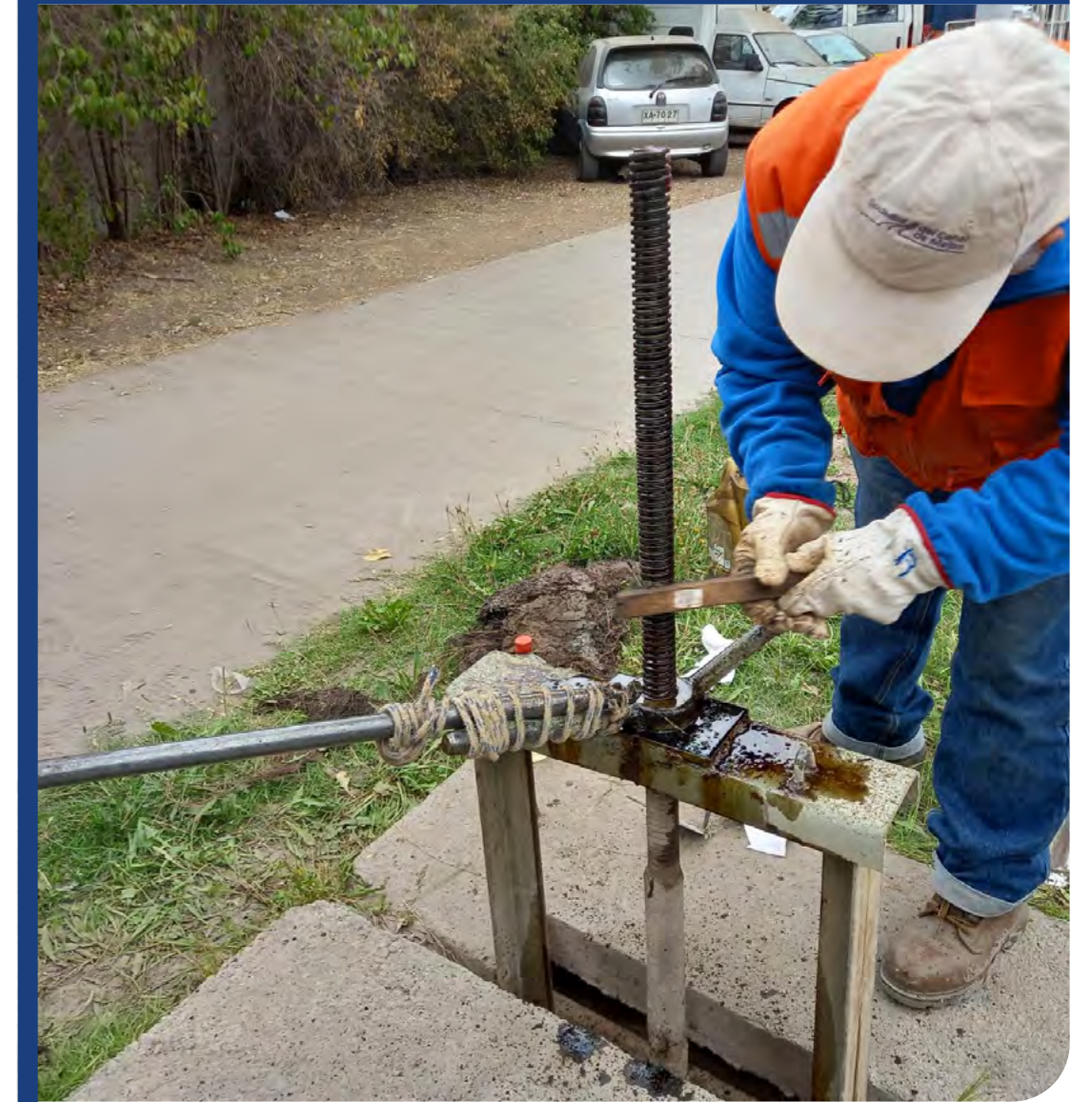
Reparación de compuerta en la comunidad Seminario Pontificio.
