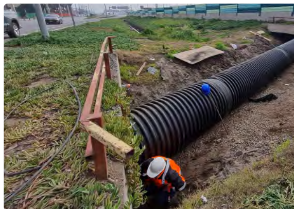
Entubamiento del Canal Lo Castro en cruce con ruta 5.
