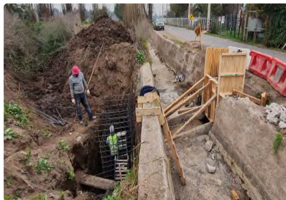
Construcción de sifón en comunidad Casas El Alba, derivada marco N° 2 Canal Batuco.
