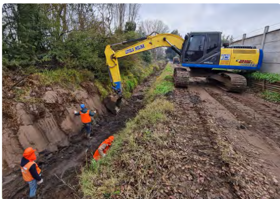
510 metros lineales de revestimiento en Canal Batuco aguas abajo sector Lo Pinto.
