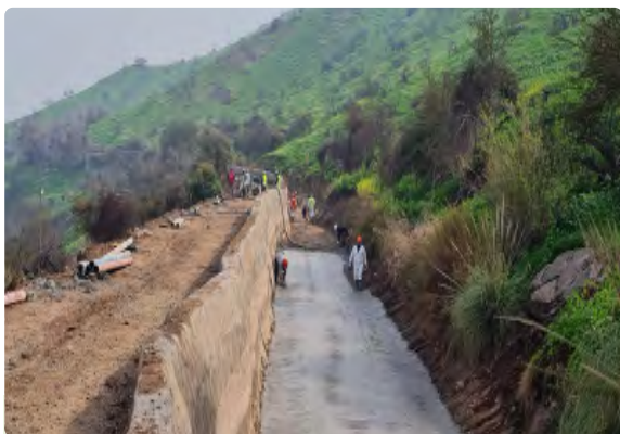
1.000 metros lineales de radier, Canal El Carmen aguas arriba sector Portezuelo.
