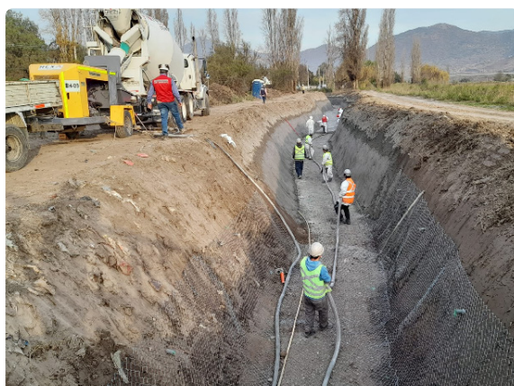
Canal Colina, revestimiento aguas abajo El Alba.
