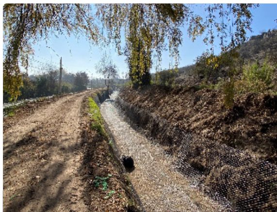
Canal Batuco, revestimiento aguas abajo radial nororiental.
