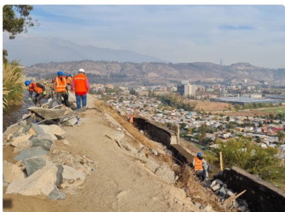
Canal El Carmen, construcción de 300 metros lineales de muros de camino de borde , aguas arriba de Recoleta.
