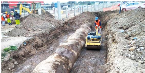
Modificación del canal, cambiando su trazado, de 580 metros de longitud, debido a un desarrollo de infraestructura que afectaba el trazado original.
