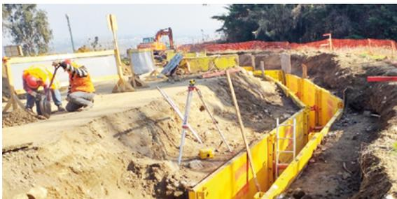
Alcantarillado paralelo al canal, como parte de un proyecto inmobiliario en Huechuraba. Para evitar daños en el canal, se utilizó una técnica de entibación.
