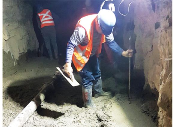
Radier en el túnel nuevo: se tuvo que bombear el hormigón a más de 50 metros de altura para ingresarlo al túnel y luego nivelarlo.
