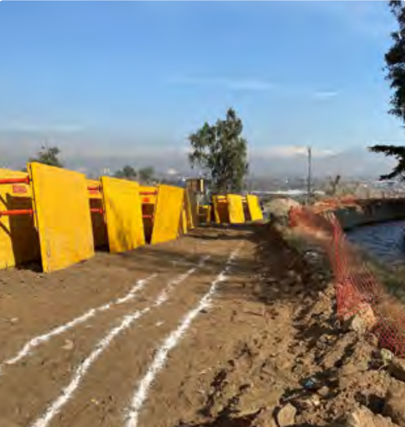
Es parte de la solución de alcantarillado de un proyecto inmobiliario en Huechuraba. Para evitar daños en el canal se utilizó una técnica de entibación.
