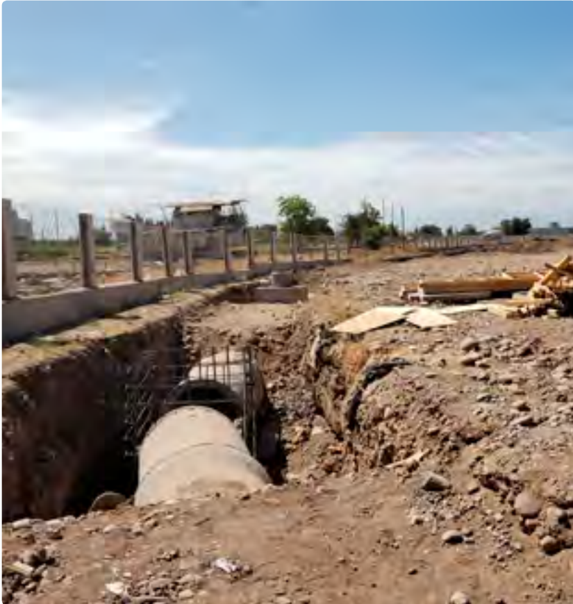
Cambio de trazado del canal Cisternas, de 580 metros de longitud, debido a un desarrollo de infraestructura que afectaba el trazado original.
