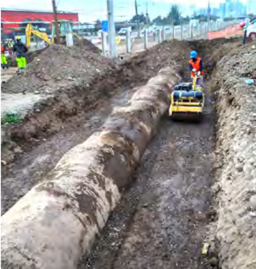
Cambio de trazado del canal Cisternas, de 580 metros de longitud, debido a un desarrollo de infraestructura que afectaba el trazado original.
