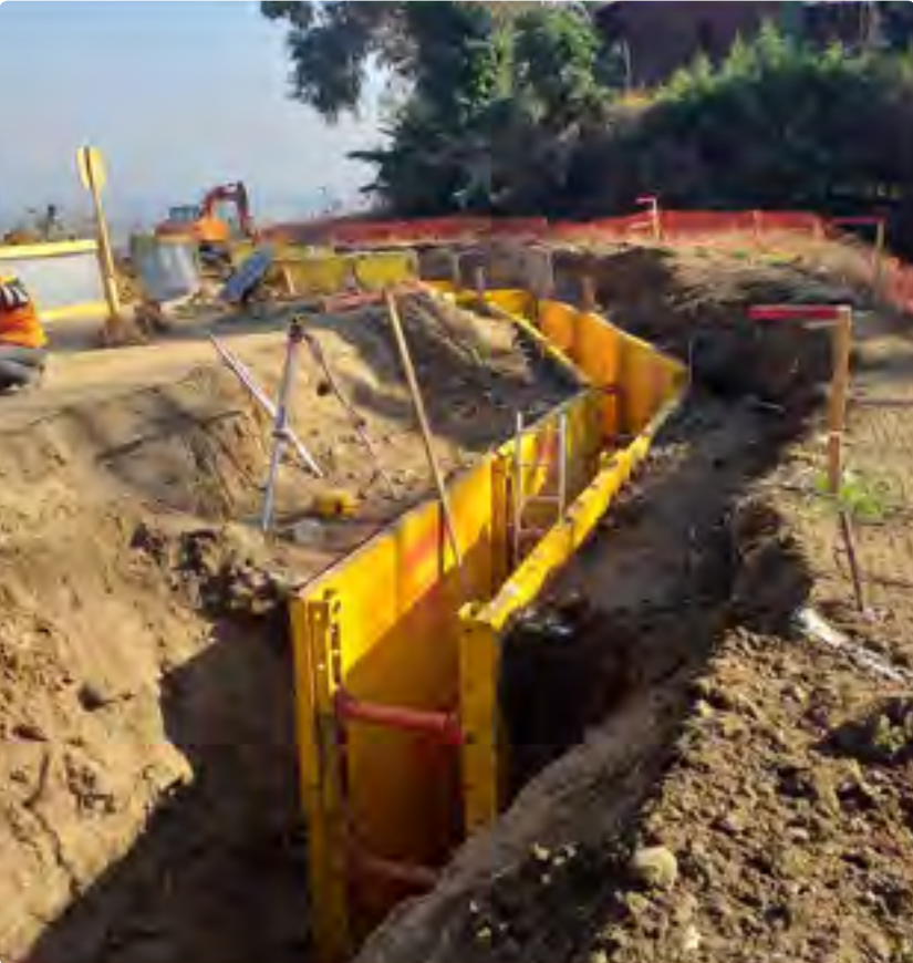
Es parte de la solución de alcantarillado de un proyecto inmobiliario en Huechuraba. Para evitar daños en el canal se utilizó una técnica de entibación.
