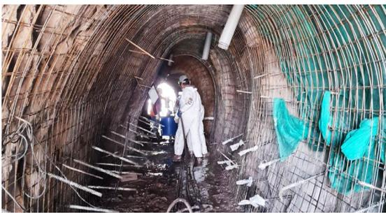
Revestimiento de túnel a base de hormigón, túnel San Ignacio, Canal El Carmen.
