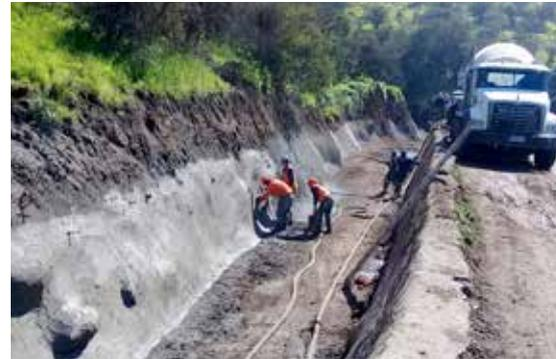
Para mejorar el escurrimiento y evitar la filtración lateral, se aplicó revestimiento de hormigón proyectado en 640 m de ladera del cerro con un refuerzo de malla.
