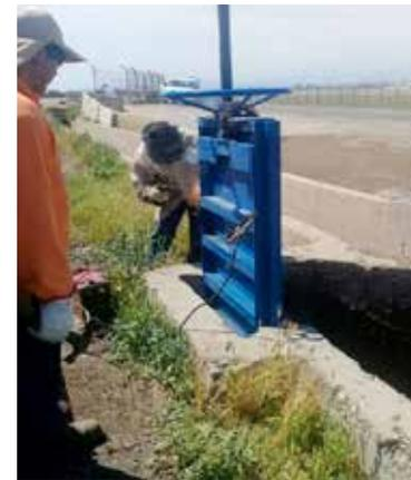
Refuerzo antivandálico en compuerta Canal La Punta.
