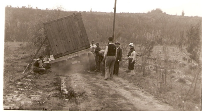
Traslado de piezas de la Unidad N°2 desde estación FFCC
