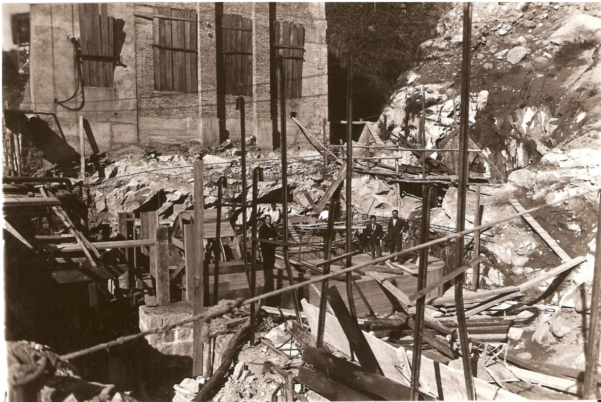
Fundación de las descargas de la Turbina N°2 Leffel, 1942
