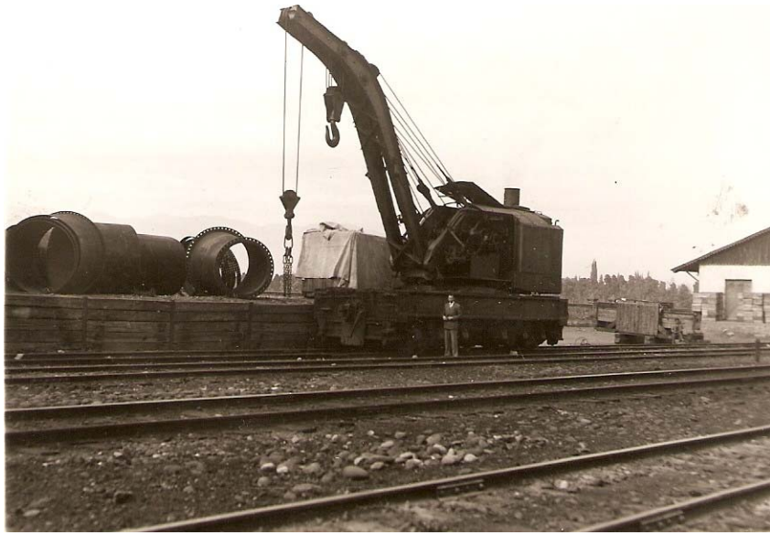
Cargando tuberías de presión en la estación de FFCC
