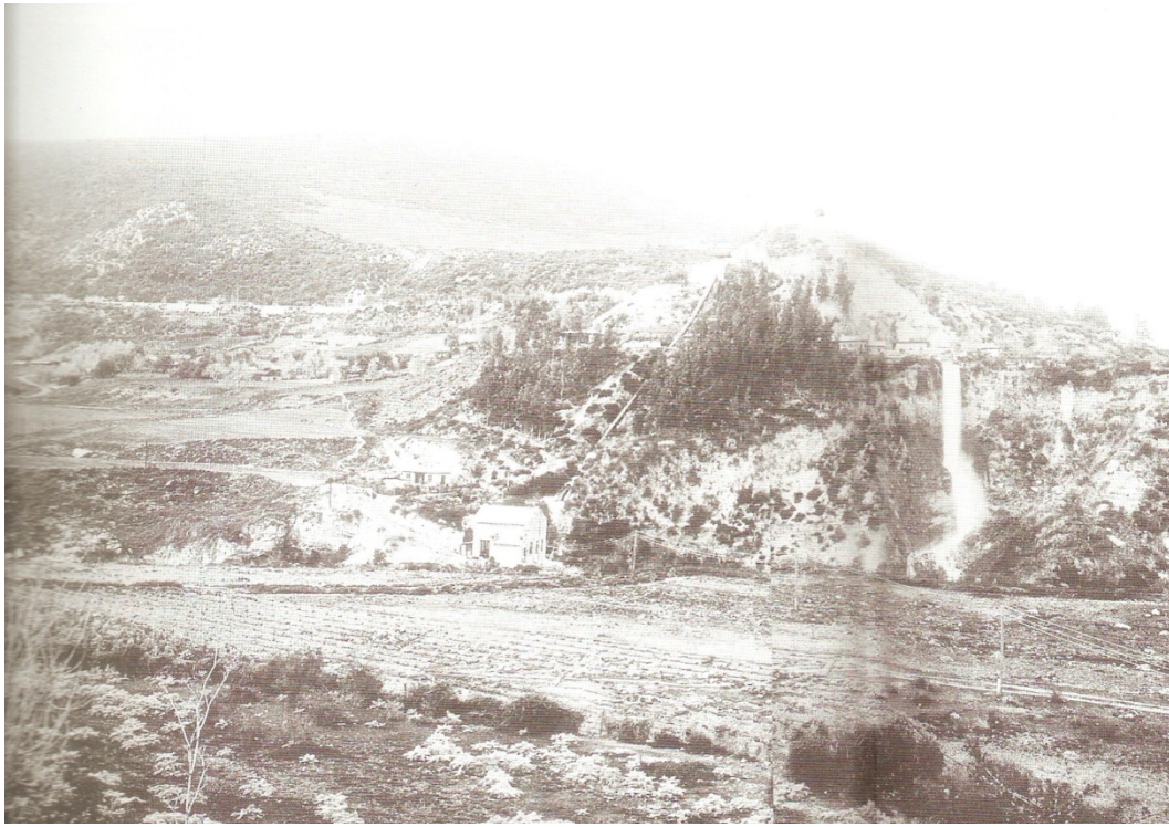
Vista de Casa de Máquina N° 1 y rápido de descarga
