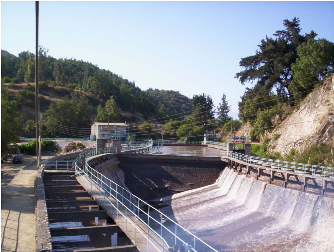
Nave desarenadora N°2
