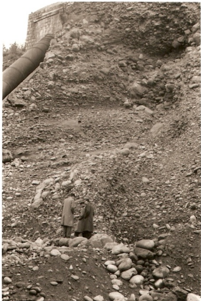
Socavón producido por falla en el caracol Unidad N°2 - Ingenieros inspeccionando los daños
