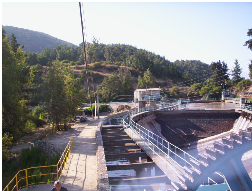
Nave desarenadora N°2
