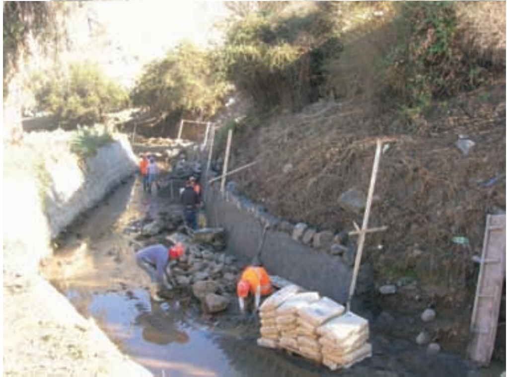
Muro Canal El Carmen.
