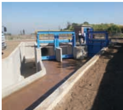
Canal San Carlos viejo, nueva bocatoma Canal Perdices.
