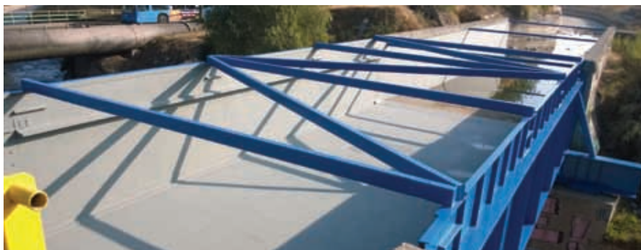
Mantenimiento Canoas Canal San Carlos.
