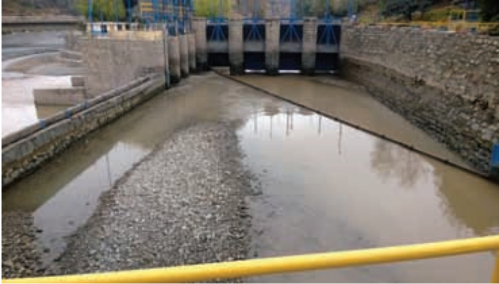
Limpieza Canal San Carlos.
