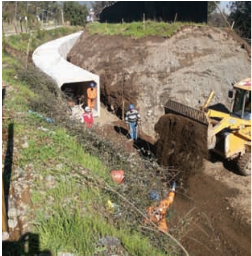
Abovedamiento Canal Perdices.
