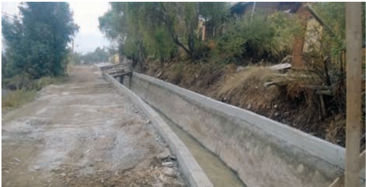
Abovedamiento Canal Colina.
