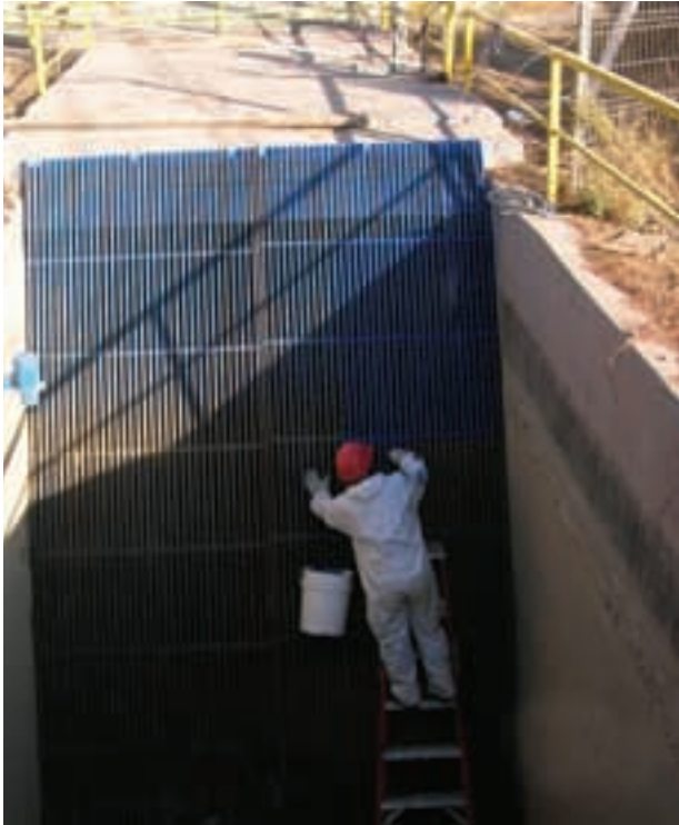
Mantenimiento de compuertas.
