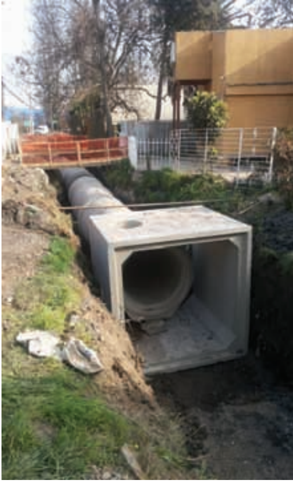
Entubamiento Canal Lo Castro.
