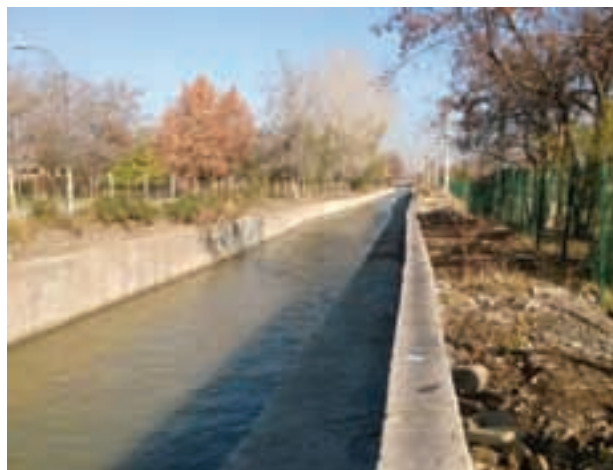
Muro Derecho Canal San Carlos.
