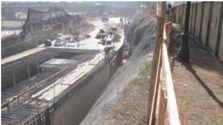
Detalle de la modificación del trazado del Canal San Carlos en su descarga al río Mapocho, con motivo de la construcción del mall Costanera Center.
