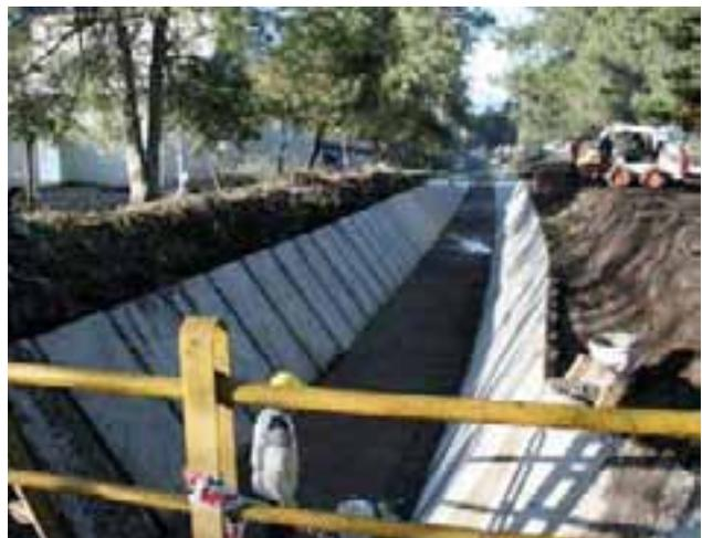
Revestimiento Canal Perdices en Planta de tratamiento de agua potable de las Vízcachas
