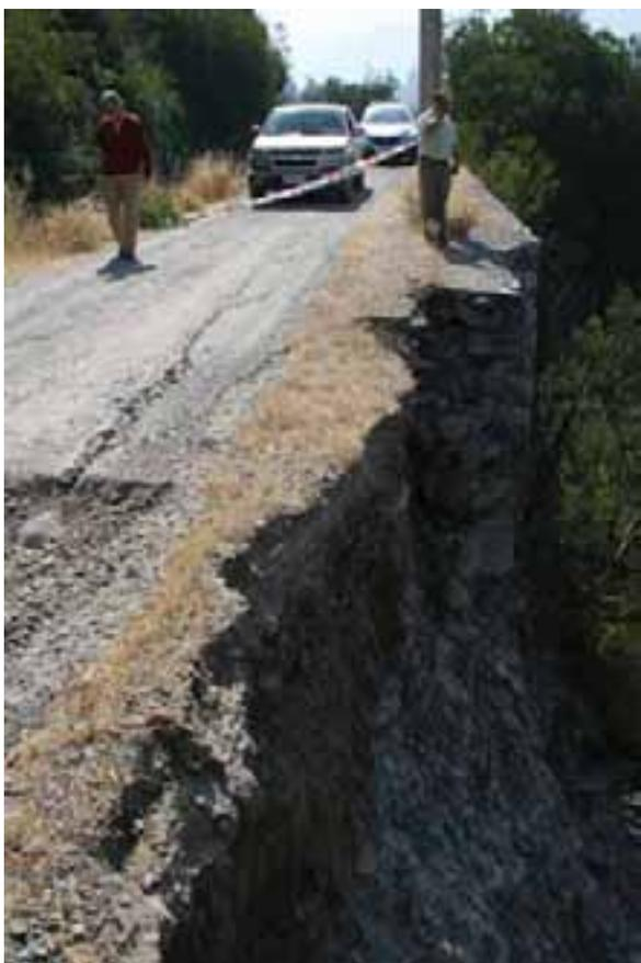
A raíz del terremoto del 27 de Febrero de 2010, se produjeron daños en algunos canales de nuestra red de riego, la que en todo caso siguió funcionando sin interrupciones, aunque se debió disminuir el caudal del canal San Carlos Tronco debido al deslizamiento de un antiguo muro de contención en el sector ubicado aguas abajo de la sección de aforo del canal, y a la caída de grandes rocas al cauce de este canal y al del canal Eyzaguirre.
