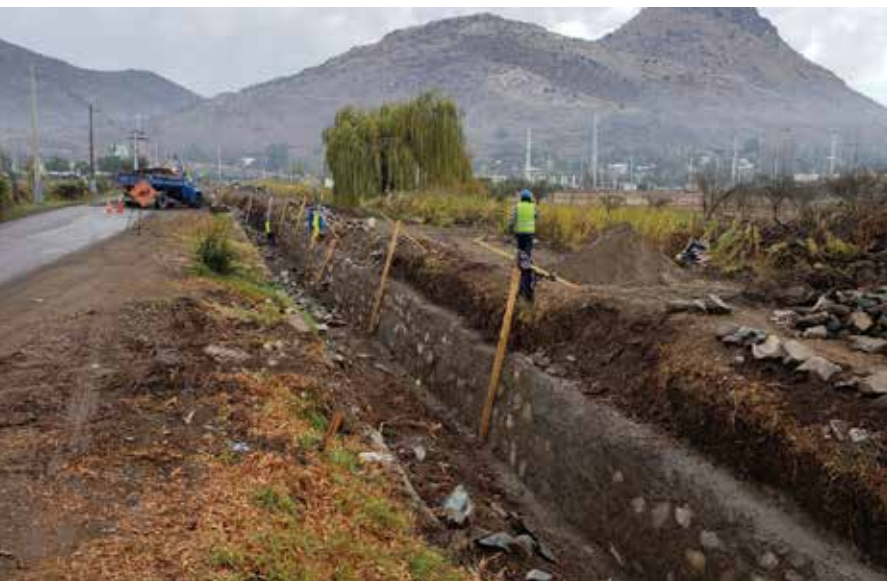
COLINA MURO IZQUIERDO PARALELO EL ALBA 1
