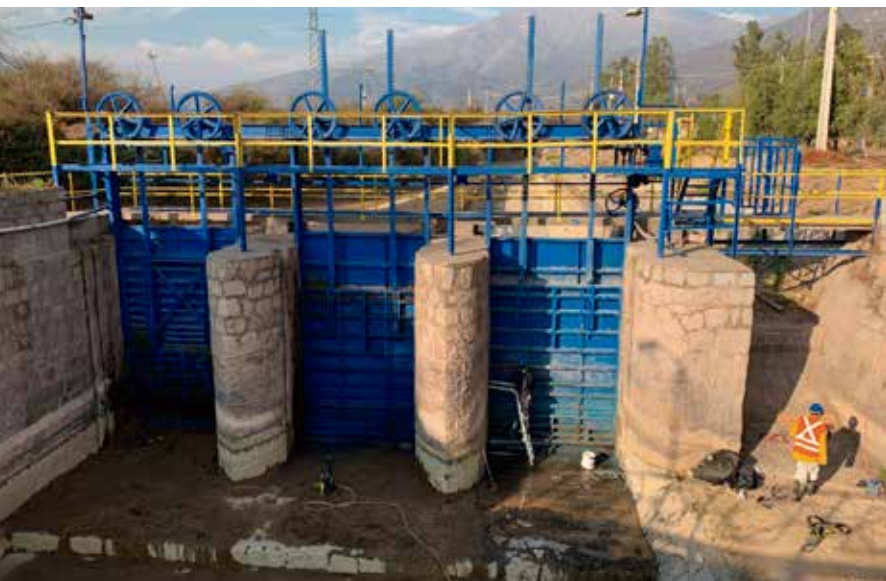
MANTENCIÓN COMPUERTAS PUENTE NEGRO
