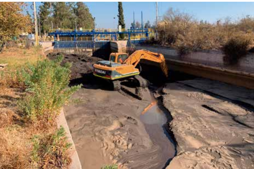
LIMPIEZA SECTOR DESARENADOR CASAS VIEJAS
