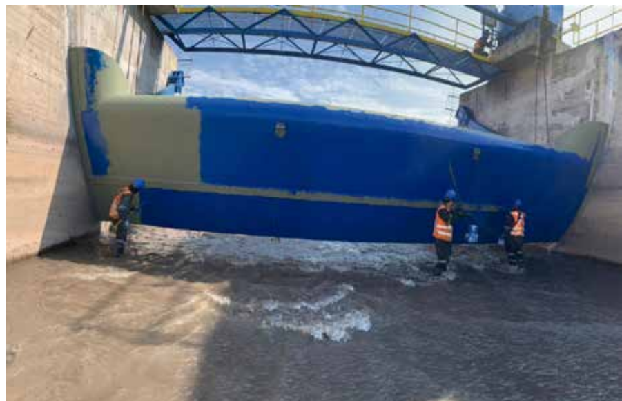
MANTENCIÓN BOCATOMA LA PUNTA
