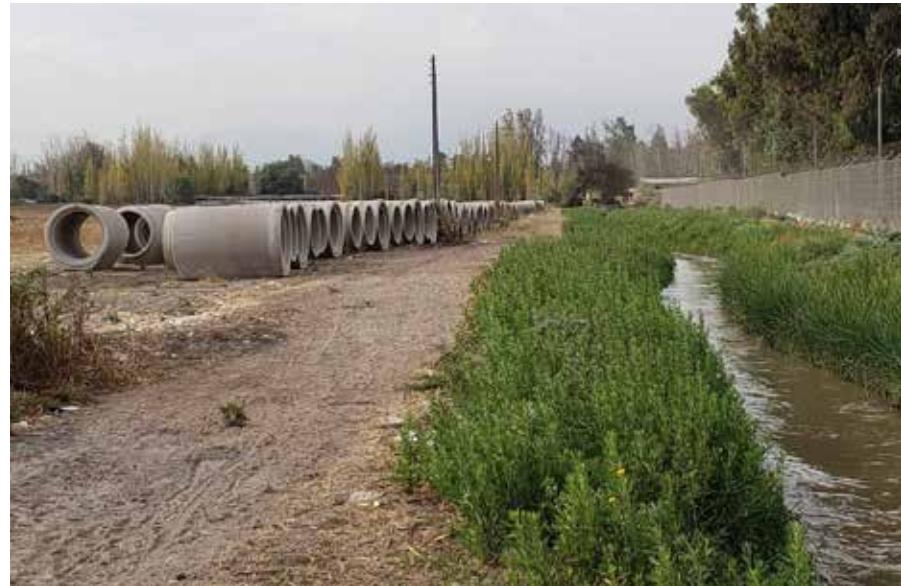
ENTUBAMIENTO LO CASTRO, AGUAS ARRIBA 5 NORTE
