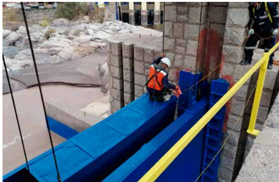
MANTENCIÓN BOCATOMA CANAL EYZAGUIRRE
