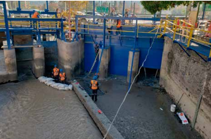
MANTENCIÓN BOCATOMA EL CARMEN
