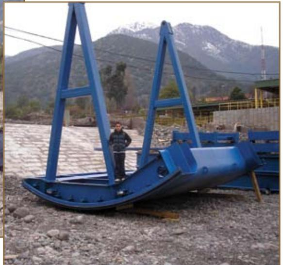
Instalación y montaje de las nuevas compuertas en la bocatoma del Canal San Carlos
