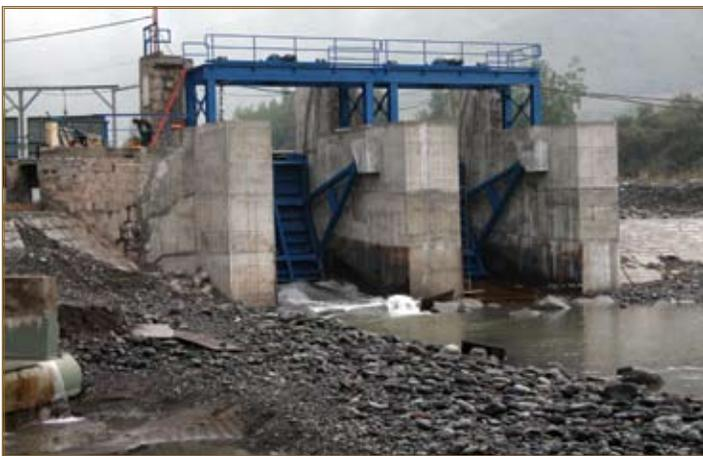
Demolición, y modificación de las antiguas obras civiles para las nuevas compuertas.
