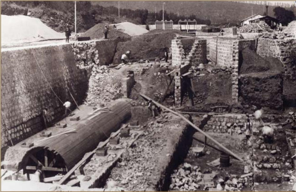
Construcción de las fundaciones y de la purga de los clarificadores al rápido de descarga
