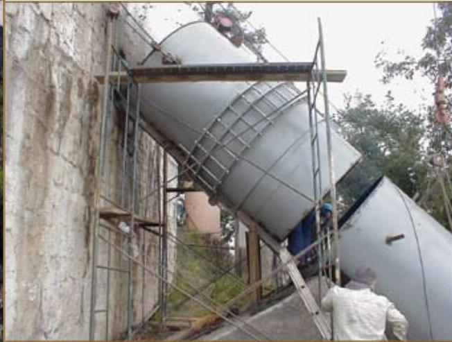
Cambio tubería de aducción para aumentar la capacidad requerida por nueva unidad
