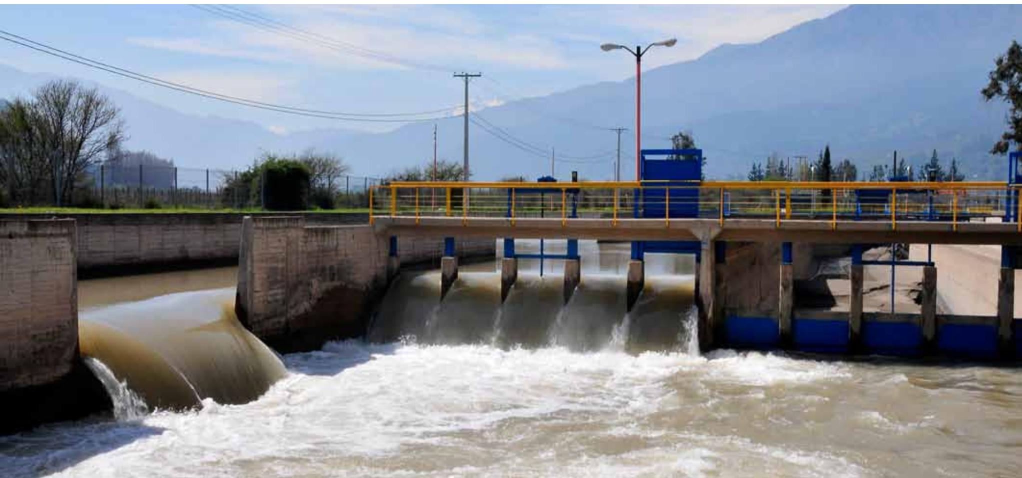
El desarenador de Casas Viejas, inaugurado a mediados de 1990, constó de tres bandejas de 100 x 10 mts. cada una, canal de aducción, túnel de purga, estanque de disipación y un canal de purga para descargar excedentes al río Maipo. Eficiente, siendo la mayor infraestructura de su tipo para un cauce de riego en Chile, este desarenador entrega además a la Sociedad permanentes ingresos por facturación de áridos.
