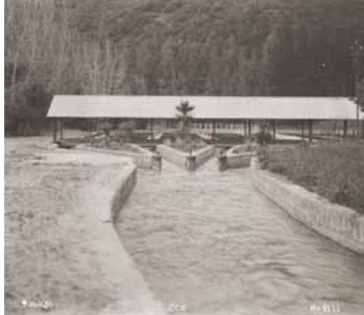
Clarificadores Planta Florida
