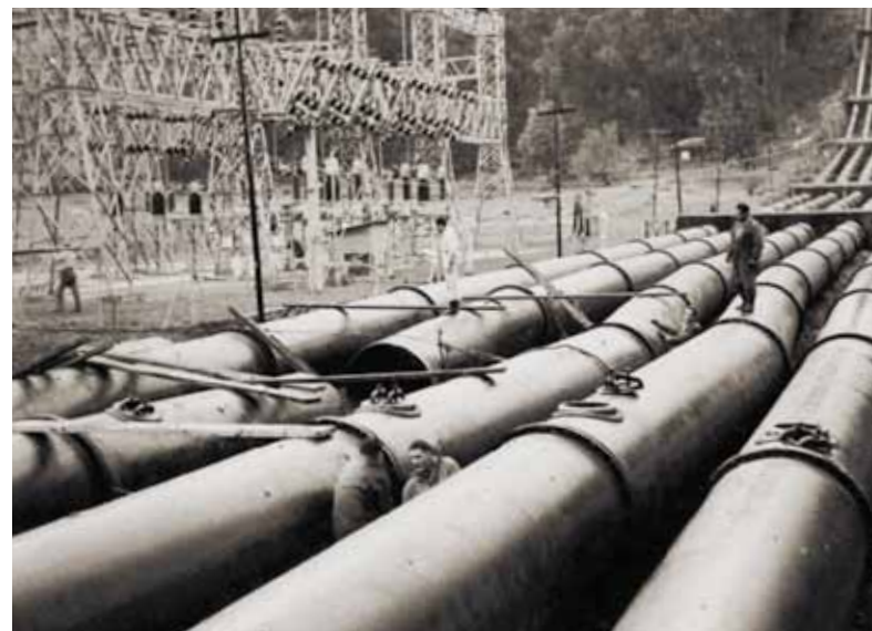
Antiguas tuberías Central Florida
