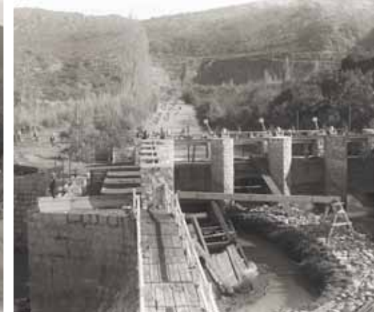
Trabajos de mantención en bocatoma San Carlos
