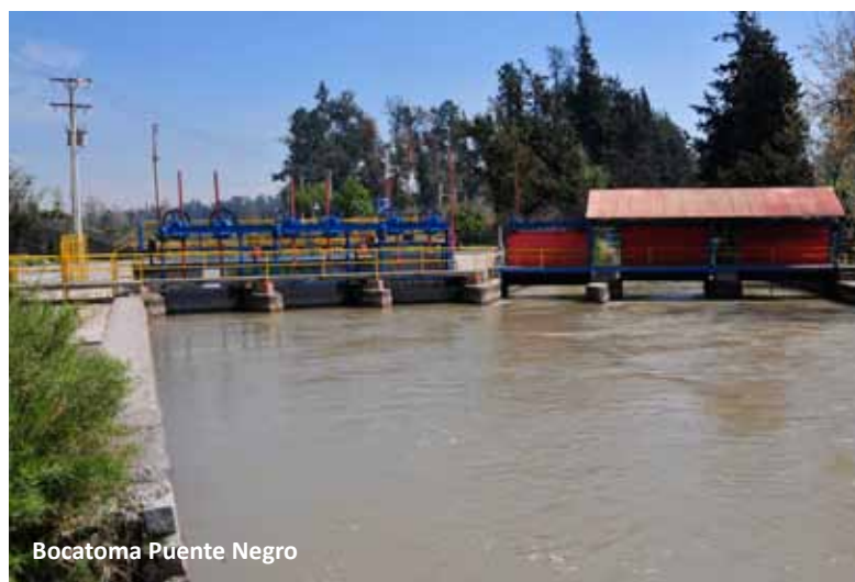
Bocatoma San Carlos
