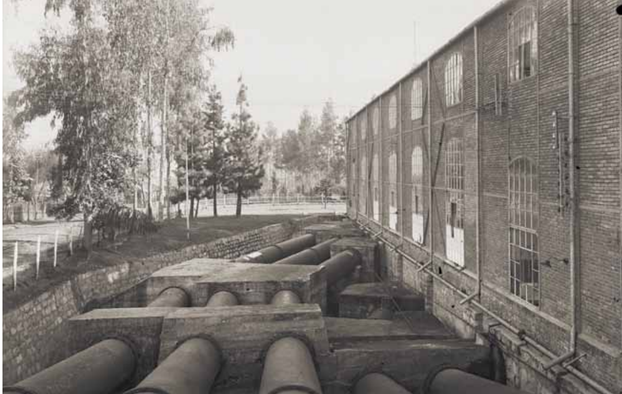
Antiguas tuberías Central Florida
